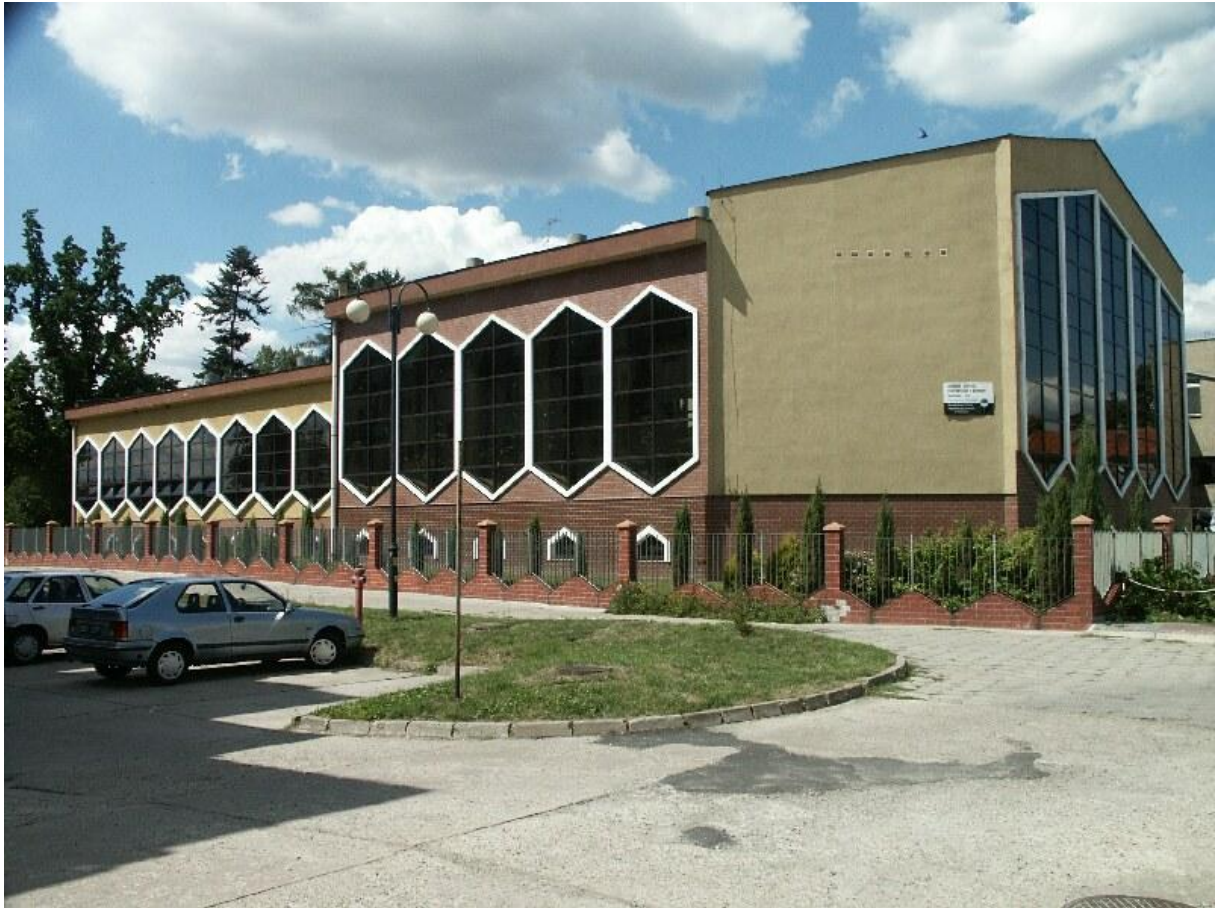
Fotografia 11. Basen kryty w Opolskim Centrum Rehabilitacji w Korfantowie
